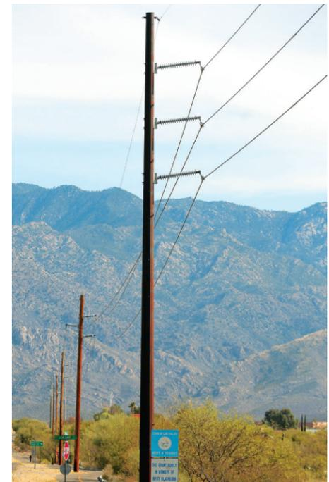
Un monopolo de Acero Corten típico que soporta una línea de transmisión de 138 kilovoltios.
