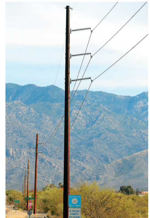
Un monopo de Acero Corten típico que soporta una línea de transmisión de 138 kilovoltios.
